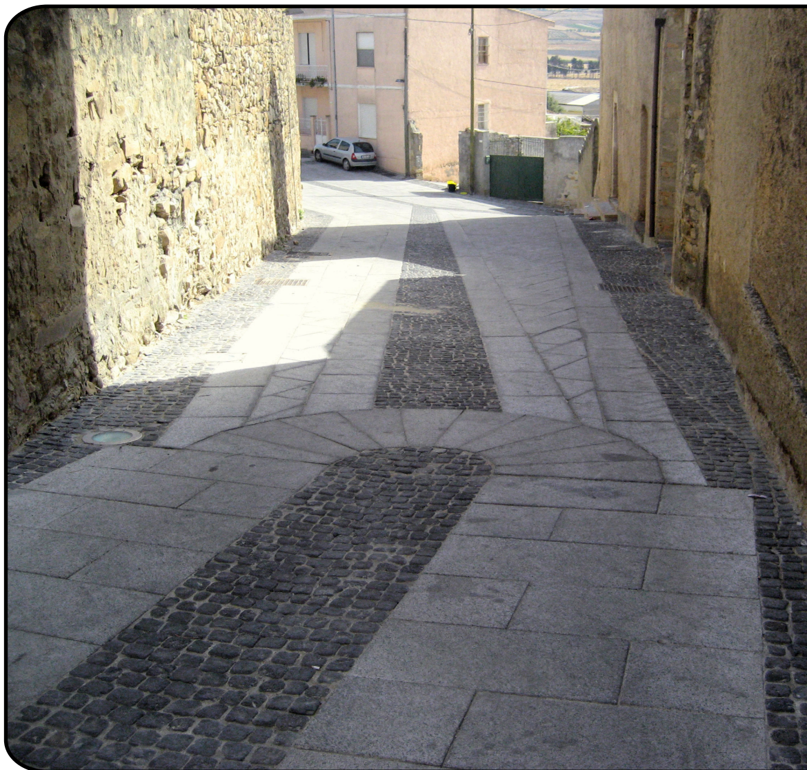
Pavimentazione con lastre in granito e ciottoli anticati in basalto. Il disegno, più articolato dei precedenti esempi, segue l'andamento della strada evidenziandone la curvatura.
