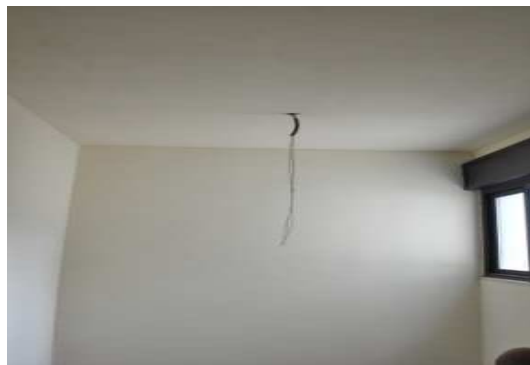
Fili scoperti in un locale adibito ad uso ripostiglio/deposito
