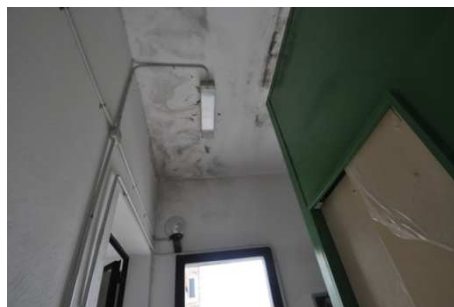
Polizia Municipale – Infiltrazione dalla copertura.
