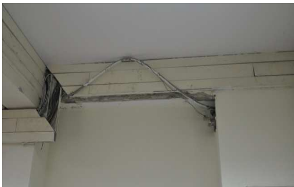
Fili scoperti all'altezza del solaio
