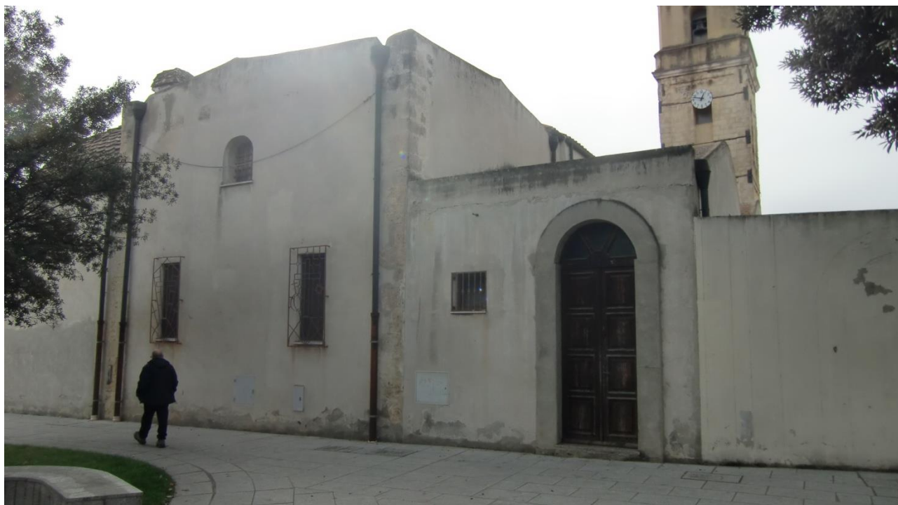
Foto 15 - Vista del fronte posteriore.
