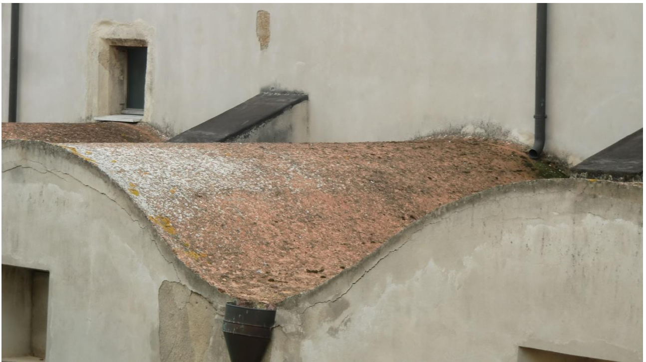
Foto 10 - Particolare del raccordo fra le volte a botte: in evidenza il degrado delle superfici estradossate.
