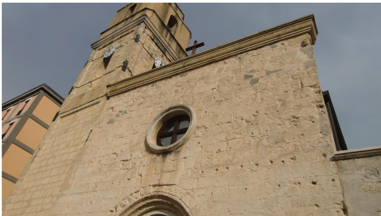
Foto n° 2 – Particolare dell'attico in copertura.
