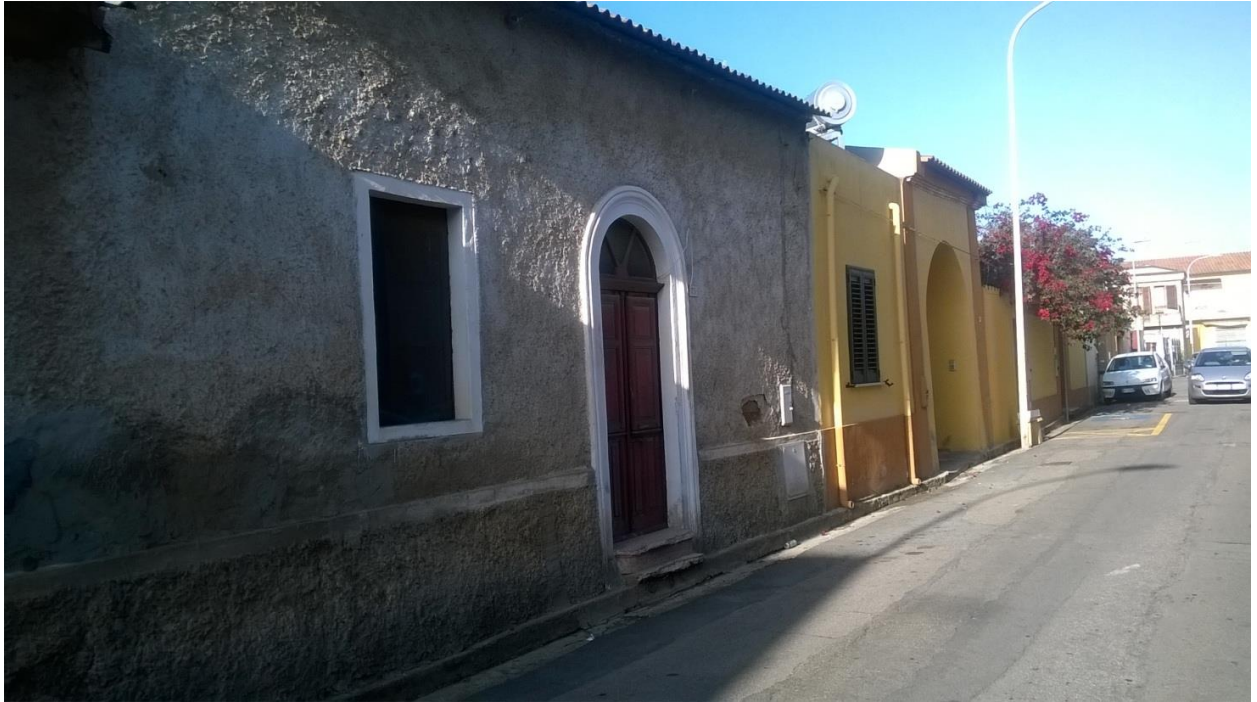
Prospetto sulla via Cagliari
