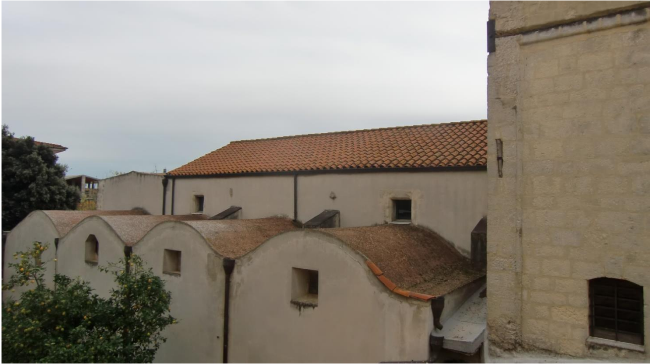
Foto 9 - La successione delle volte a botte sulle cappelle del lato sinistro
