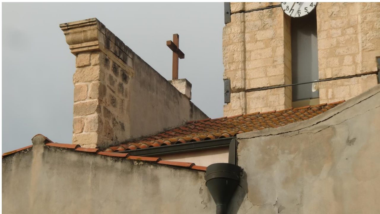
Foto 20 - Particolare compluvio fra coperture a volta della prima cappella e quella a tetto dell'oratorio. In secondo piano la navata centrale con evidenziato l'attico in copertura.
