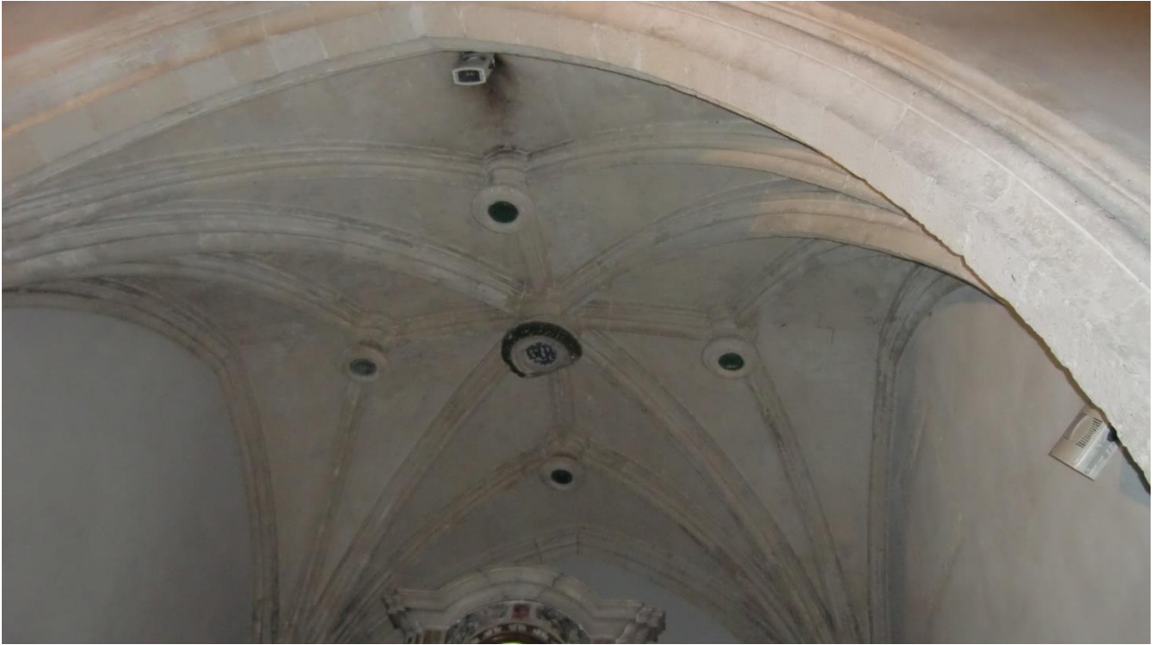
Foto 7 – Vista volta a crociera sul presbiterio: particolarmente elaborato il sistema delle nervature.
