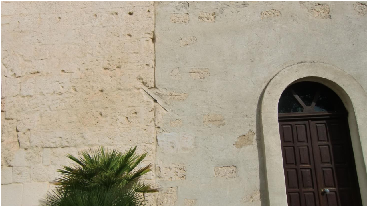
Foto n° 3 – Particolare connessione fra le mura del fronte.
